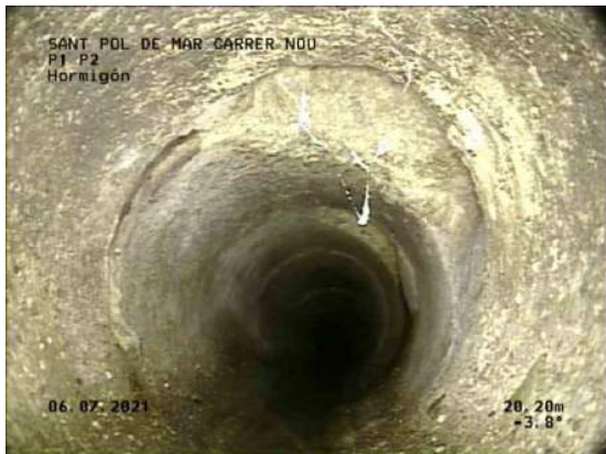
15, 00:13:52, 20.20m Unión, conexión abierta,, altura: 81mm, anchura: 81mm a 1 Reloj
