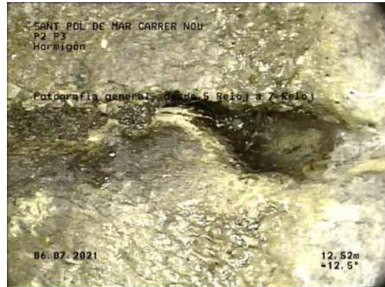
8, 00:05:59, 12.52m Fotografía general, desde 5 Reloj a 7 Reloj / JUNTA ABIERTA
