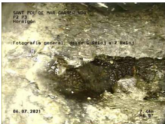
5, 00:03:34, 7.46m Fotografía general, desde 5 Reloj a 7 Reloj / JUNTA ABIERTA
