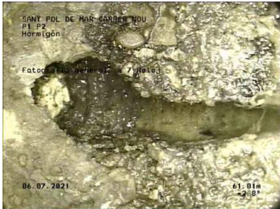
55, 00:39:19, 61.01m Fotografia general, a 7 Reloj / JUNTA ABIERTA
