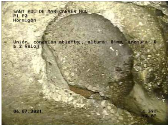
1, 00:02:24, 4.39m Unión, conexión abierta,, altura: 81mm, anchura: 81mm a 2 Reloj
