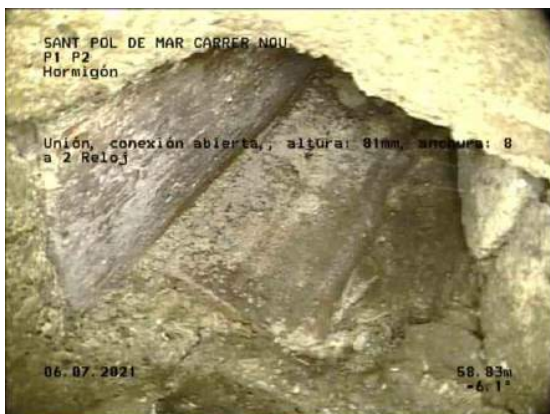
53, 00:38:15, 58.83m Unión, conexión abierta., altura: 81mm, anchura: 81mm a 2 Reloj
