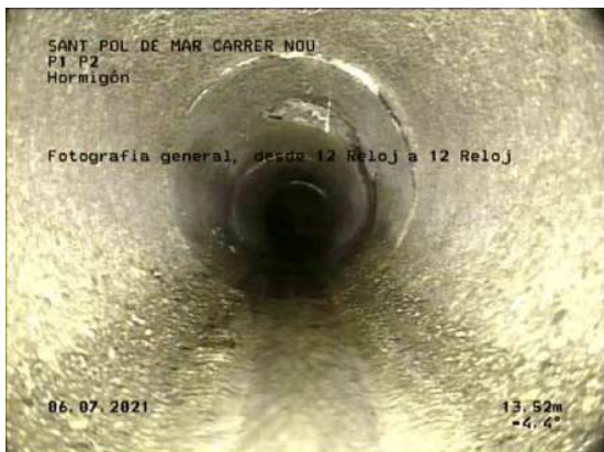
9, 00:09:30, 13.52m Fotografia general, desde 12 Reloj a 12 Reloj / DESGASTE COLECTOR
