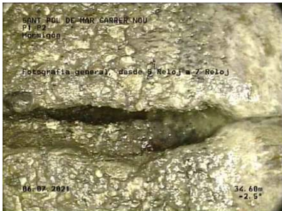
33, 00:24:25, 34.60m Fotografía general, desde 5 Reloj a 7 Reloj / JUNTA ABIERTA
