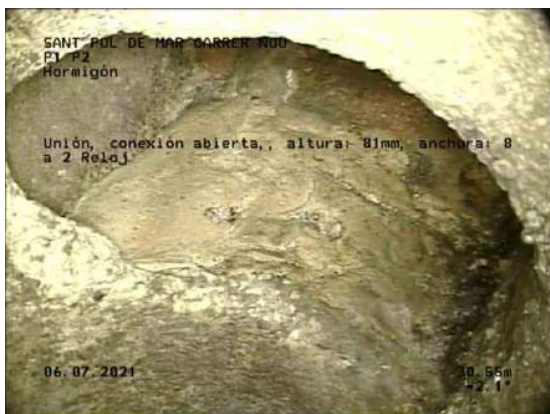
29, 00:22:18, 30.55m Unión, conexión abierta,, altura: 81mm, anchura: 81mm a 2 Reloj
