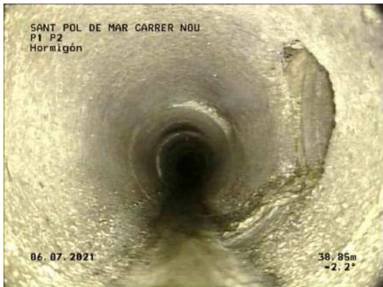
39, 00:28:27, 38.85m Unión, conexión abierta,, altura: 81mm, anchura: 81mm a 3 Reloj
