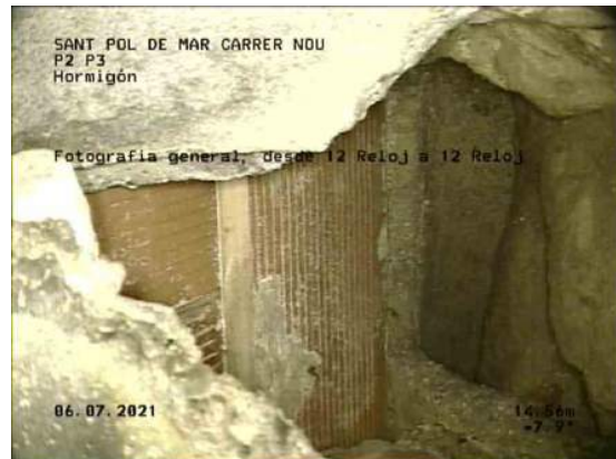
10, 00:07:10, 14.56m Fotografía general, desde 12 Reloj a 12 Reloj / ROTURA
