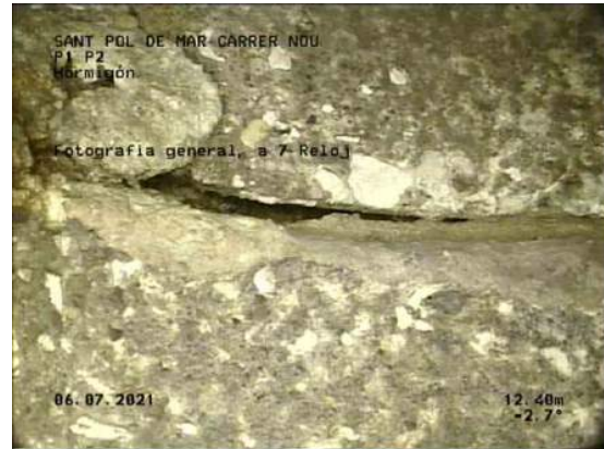
8, 00:08:43, 12.40m Fotografia general, a 7 Reloj / JUNTA ABIERTA
