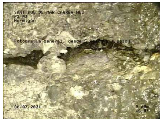
6, 00:04:39, 9.49m Fotografía general, desde 5 Reloj a 7 Reloj / JUNTA ABIERTA
