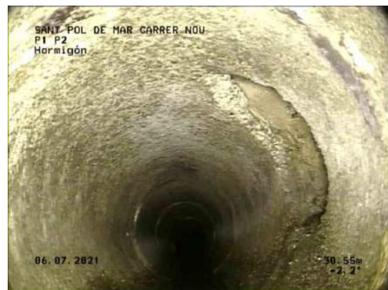
30, 00:22:18, 30.55m Unión, conexión abierta,, altura: 81mm, anchura: 81mm a 2 Reloj
