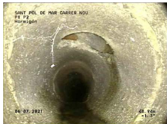
48, 00:33:50, 48.94m Unión, conexión abierta,, altura: 81mm, anchura: 81mm a 1 Reloj
