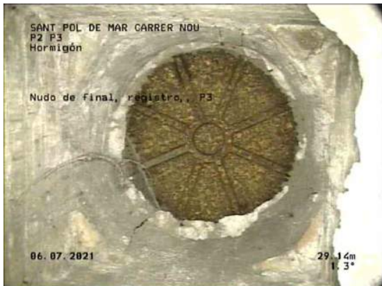
15, 00:14:41, 29.14m Nudo de final, registro,, P3 / ACOMETIDAS EN POZO
