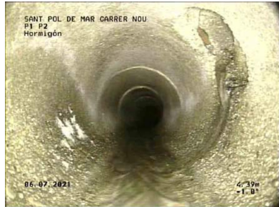
2, 00:02:24, 4.39m Unión, conexión abierta,, altura: 81mm, anchura: 81mm a 2 Reloj
