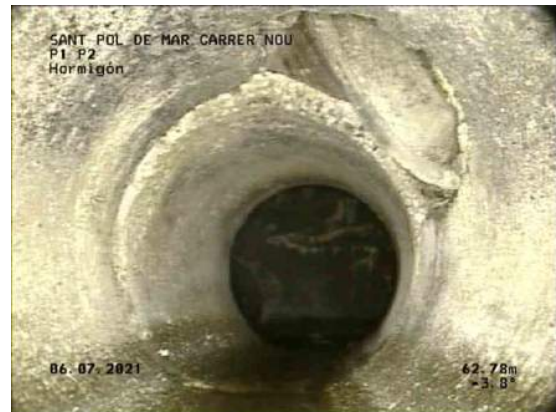
58, 00:40:10, 62.78m Unión, conexión abierta., altura: 81mm, anchura: 81mm a 1 Reloj
