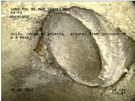
1, 00:00:10, 1.15m Unión, conexión abierta,, altura: 81mm, anchura: 81mm a 2 Reloj
