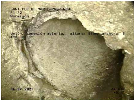
43, 00:31:31, 44.64m Unión, conexión abierta,, altura: 81mm, anchura: 81mm a 2 Reloj
