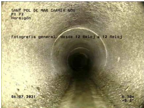
3, 00:04:09, 6.30m Fotografía general, desde 12 Reloj a 12 Reloj / DESGASTE COLECTOR
