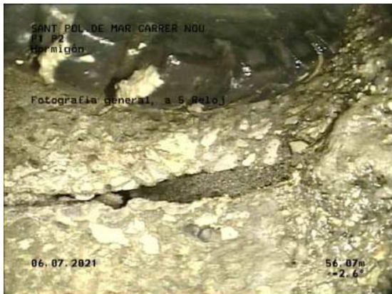
51, 00:37:16, 56.07m Fotografía general, a 5 Reloj / JUNTA ABIERTA
