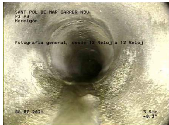
4, 00:01:30, 3.51m Fotografía general, desde 12 Reloj a 12 Reloj / DESGASTE COLECTOR
