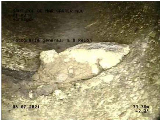
31, 00:23:42, 33.38m Fotografía general, a 8 Reloj / HORMIGON
