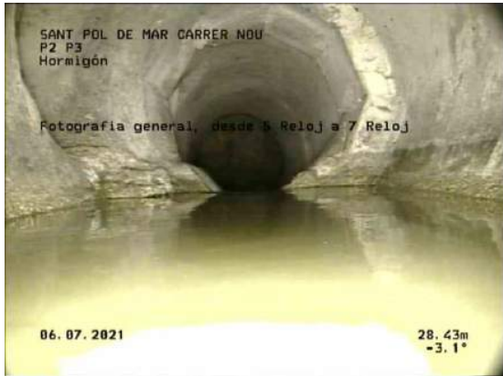
13, 00:13:42, 28.43m Fotografia general, desde 5 Reloj a 7 Reloj / NIVEL DE AGUA 25%
