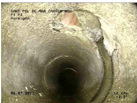
11, 00:10:14, 14.47m Unión, conexión abierta,, altura: 81mm, anchura: 81mm a 1 Reloj
