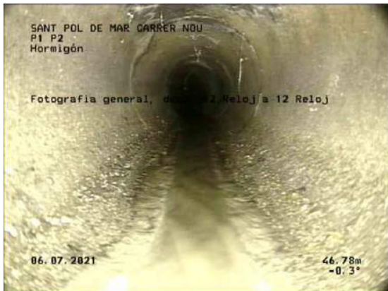
45, 00:32:44, 46.78m Fotografía general, desde 12 Reloj a 12 Reloj / DESGASTE COLECTOR
