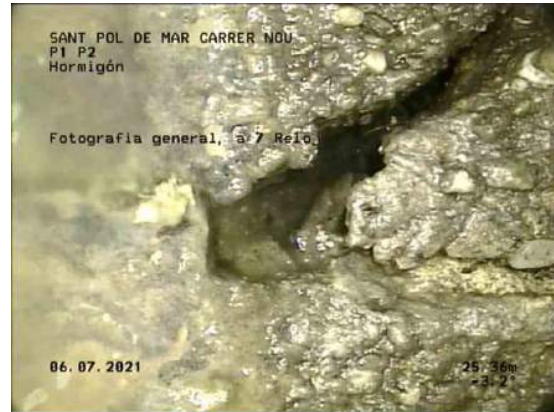
26, 00:19:58, 25.36m Fotografía general, a 7 Reloj / JUNTA ABIERTA
