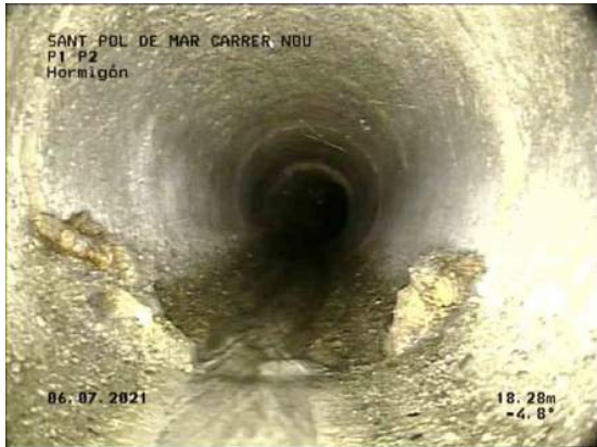
13, 00:12:42, 18.28m Fotografía general, desde 5 Reloj a 7 Reloj / HORMIGON
