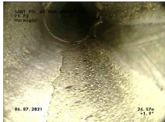
22, 00:18:26, 24.57m Fotografía general, a 7 Reloj / INICIO DE GRIETA
