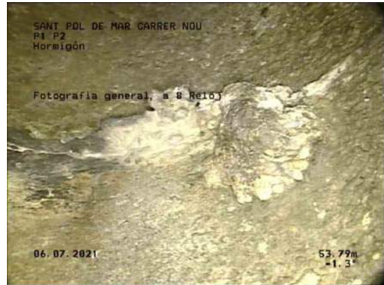
50, 00:36:11, 53.79m Fotografía general, a 8 Reloj / HORMIGON
