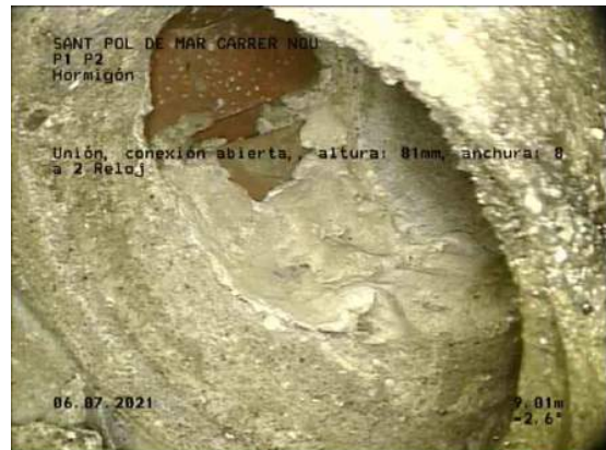
4, 00:05:36, 9.01m Unión, conexión abierta,, altura: 81mm, anchura: 81mm a 2 Reloj
