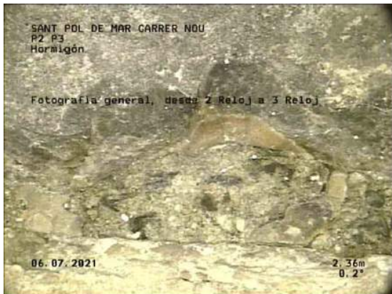
3, 00:00:37, 2.36m Fotografía general, desde 2 Reloj a 3 Reloj / ROTURA
