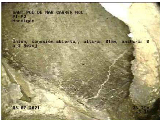
23, 00:19:01, 25.21m Unión, conexión abierta,, altura: 81mm, anchura: 81mm a 2 Reloj
