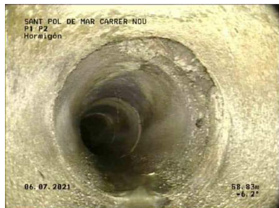
54, 00:38:15, 58.83m Unión, conexión abierta., altura: 81mm, anchura: 81mm a 2 Reloj
