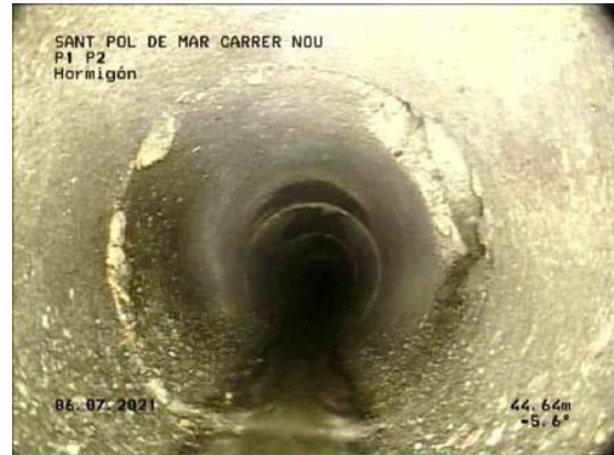
44, 00:31:31, 44.64m Unión, conexión abierta,, altura: 81mm, anchura: 81mm a 2 Reloj
