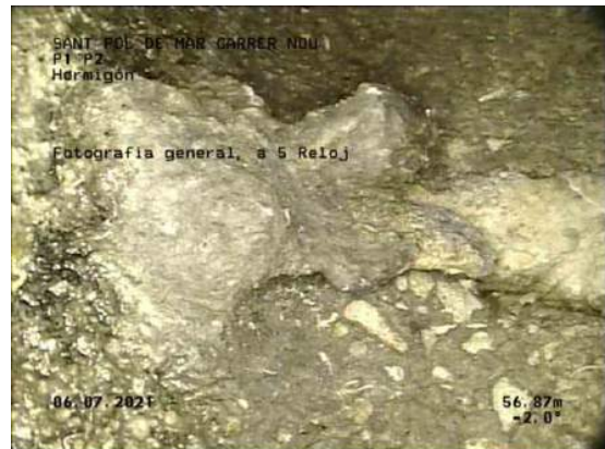
52, 00:37:34, 56.87m Fotografía general, a 5 Reloj / HORMIGON
