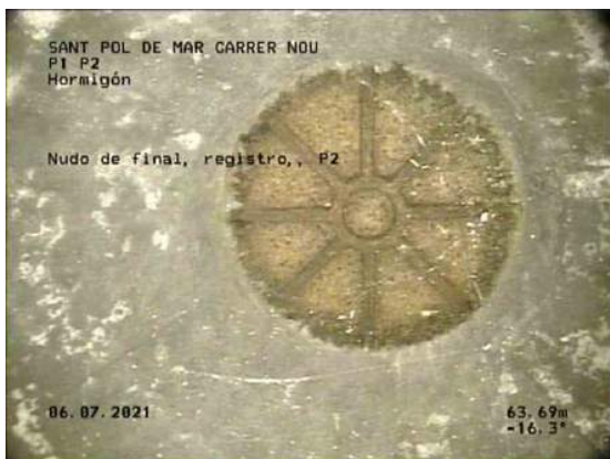
59, 00:41:37, 63.69m Nudo de final, registro., P2 / ACOMETIDA EN POZO
