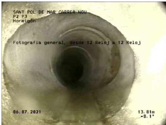
9, 00:14:56, 13.81m Fotografía general, desde 12 Reloj a 12 Reloj / CAMBIO DE DIAMETRO
