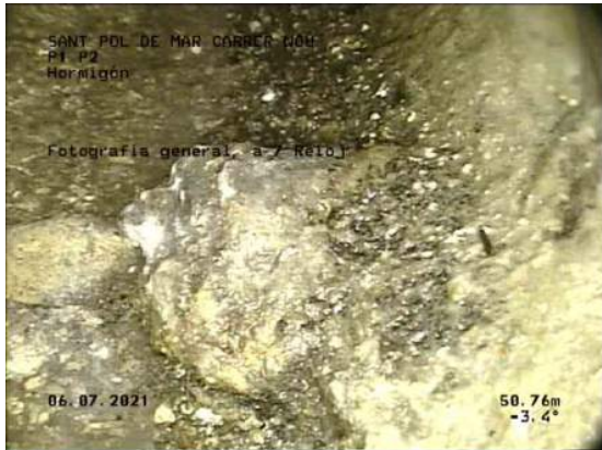
49, 00:35:01, 50.76m Fotografía general, a 7 Reloj / HORMIGON
