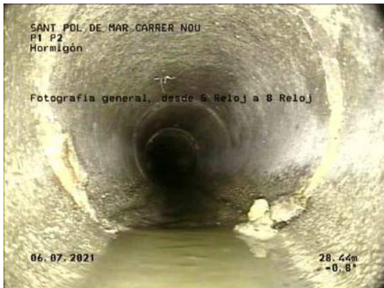
27, 00:21:16, 28.44m Fotografía general, desde 5 Reloj a 8 Reloj / HORMIGON
