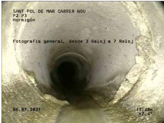
7, 00:05:24, 11.48m Fotografía general, desde 3 Reloj a 7 Reloj / HORMIGON
