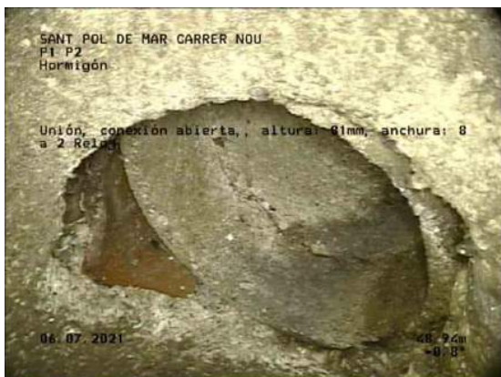
47, 00:33:50, 48.94m Unión, conexión abierta,, altura: 81mm, anchura: 81mm a 2 Reloj
