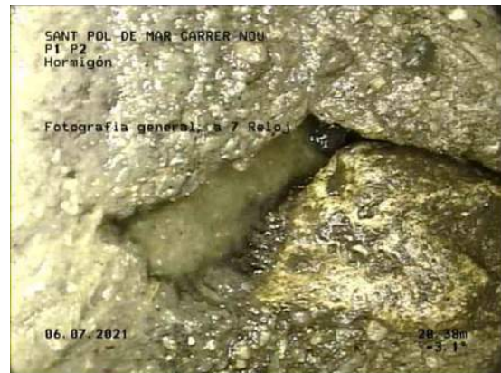
16, 00:14:29, 20.38m Fotografía general, a 7 Reloj / JUNTA ABIERTA
