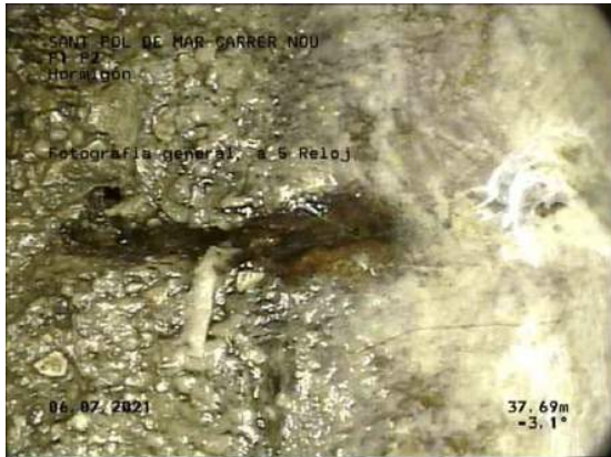
37, 00:27:44, 37.69m Fotografia general, a 5 Reloj / JUNTA ABIERTA
