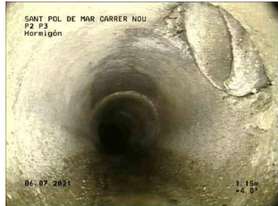
2, 00:00:10, 1.15m Unión, conexión abierta,, altura: 81mm, anchura: 81mm a 2 Reloj
