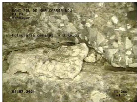
6, 00:07:41, 11.26m Fotografía general, a 3 Reloj / ROTURA
