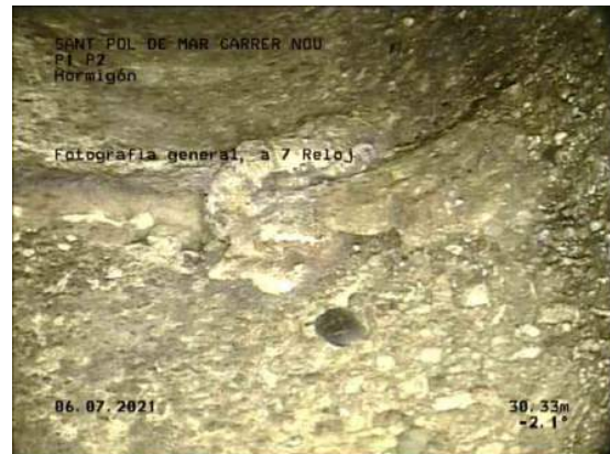
28, 00:22:06, 30.33m Fotografía general, a 7 Reloj / HORMIGON
