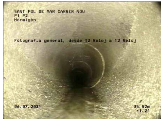
34, 00:25:39, 35.52m Fotografía general, desde 12 Reloj a 12 Reloj / INICIO GRIETAS
