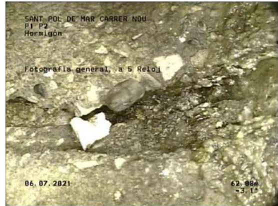
56, 00:39:54, 62.08m Fotografia general, a 5 Reloj / JUNTA ABIERTA
