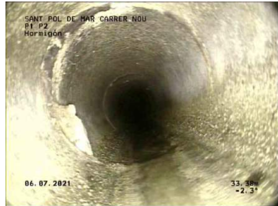
32, 00:23:42, 33.38m Fotografía general, a 8 Reloj / HORMIGON
