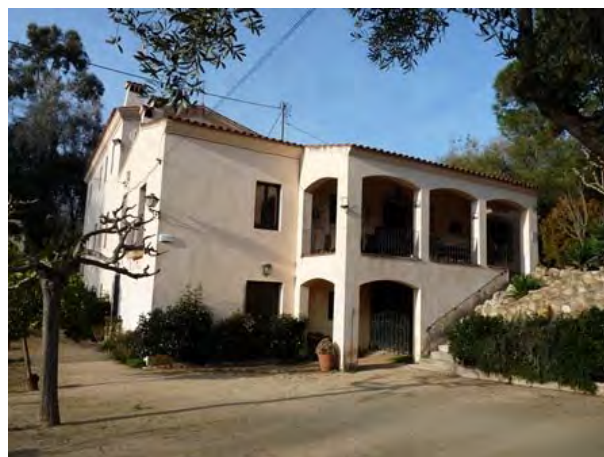
F2 Façana principal sud-est (Volum A)
