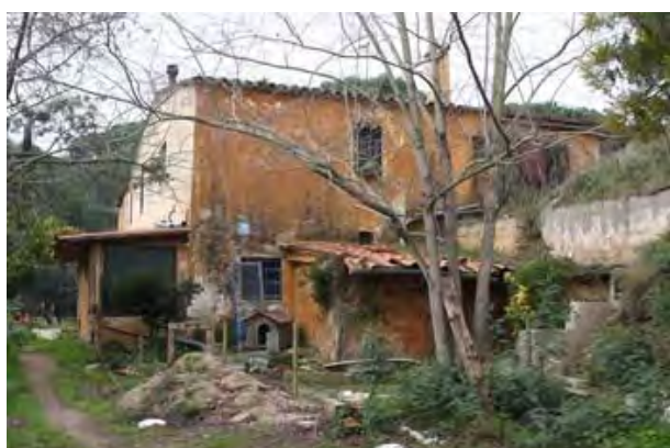
F1 Vista general accés (Volums A,C i D)
