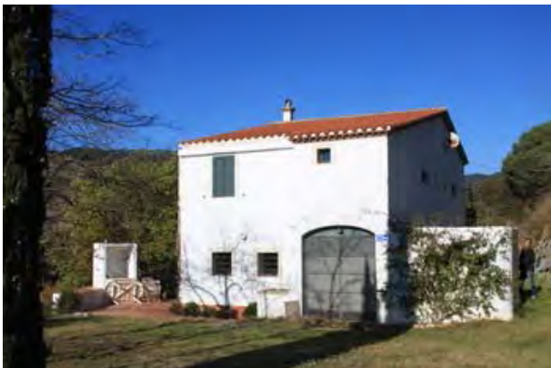
F5 Façana lateral sud (Volum A i B)
