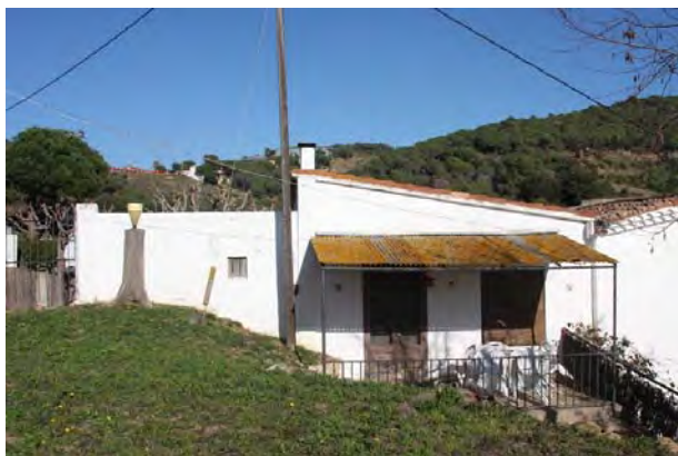
F3 Façana principal sud-oest (Volum E)
