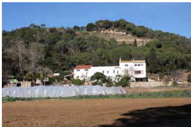
F1 Vista general façana sud
