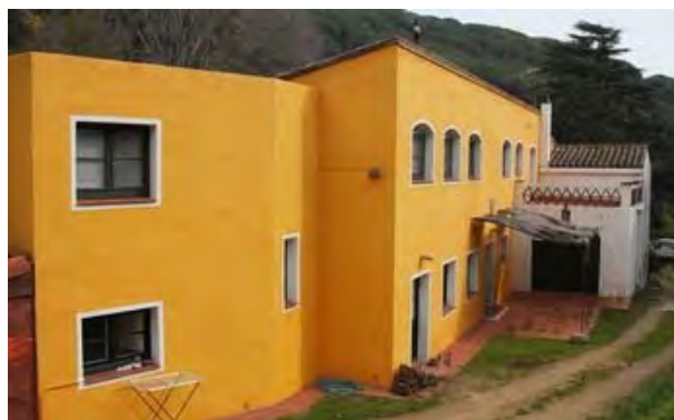
F8 Façana lateral sud-oest (Volums H,G i F)
