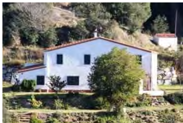
F2 Vista general façana principal oest
