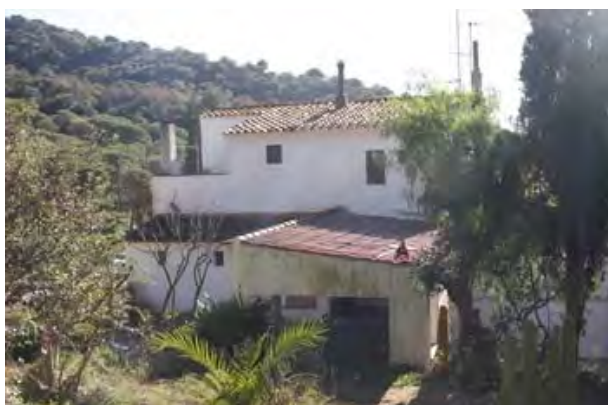
F5 Façana nord (Volum A i B)
