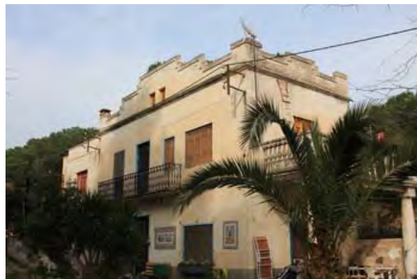
F2 Façana principal sud-oest (Volum A)
