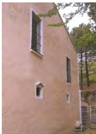
F7 Façana lateral nord-est (Volum A)
