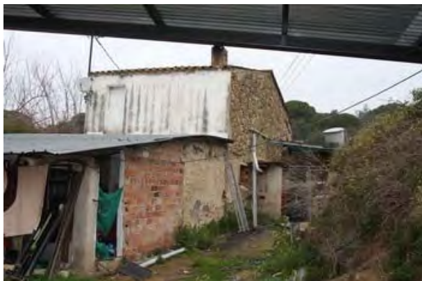
F7 Façana posterior/lateral sud (Volums B,C i A)
