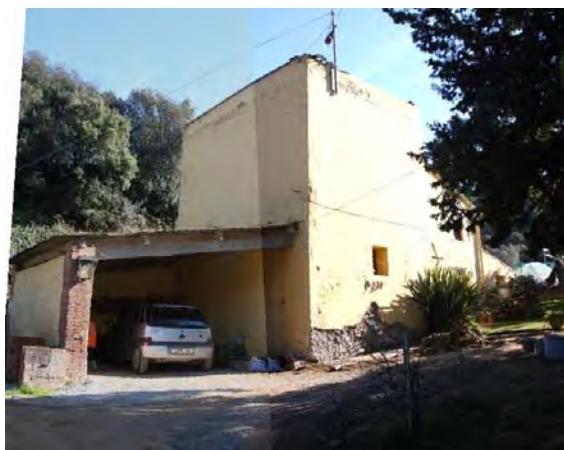
F7 Façana principal sud- oest (Volums E i B)
