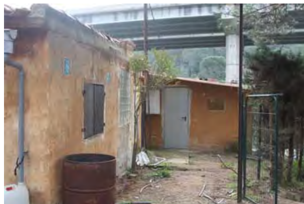
F6 Façana posterior nord (Volums E,A i B)
