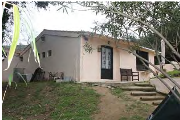
F8 Façana principal sud-oest volum E
