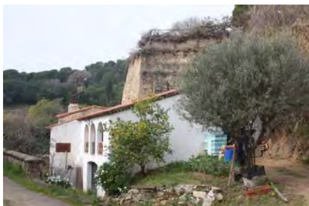
F1 Vista general camí accés
