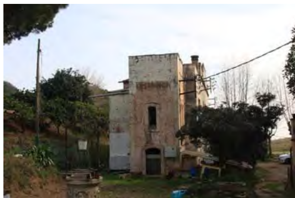
F10 Façana posterior nord-oest i pou (Volum C)
