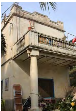
F9 Façana sud-oest (Volum A)
