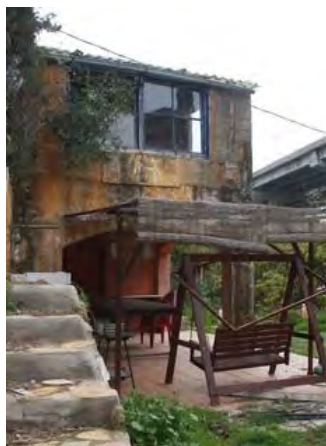
F3 Façana lateral (Volum B)
