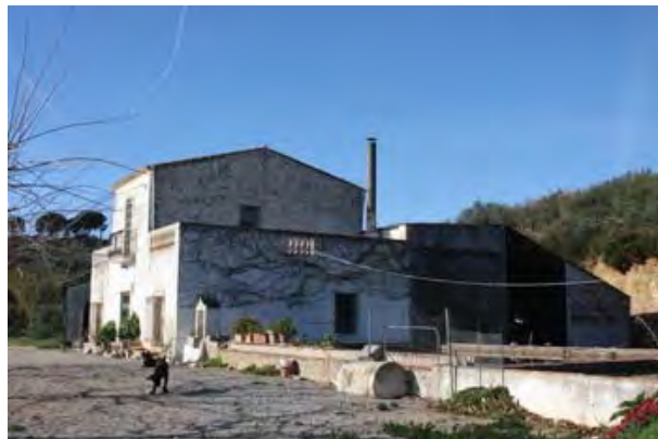
F8 Façana lateral nord-est (Volum A,B i C)
