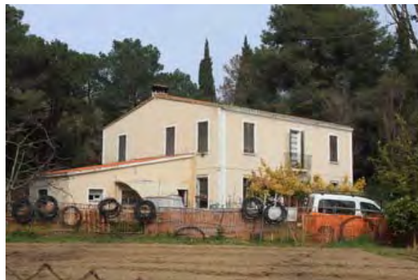
F2 Façana principal sud-est (Volum A i B)
