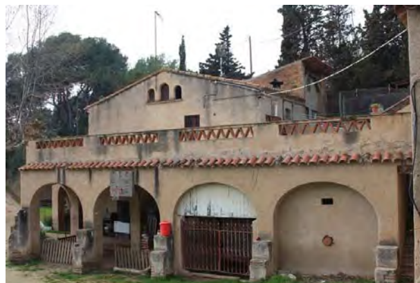
F4 Façana lateral est (Volums B i A)
