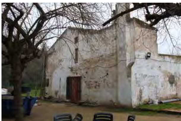
F5 Façana sud (Volum A)
