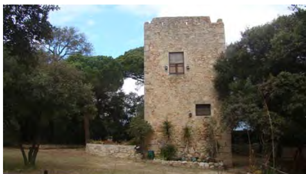
F1 Vista general façana sud
