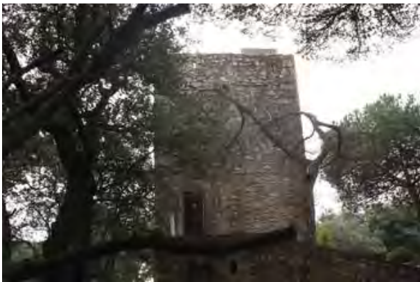
F5 Façana nord
