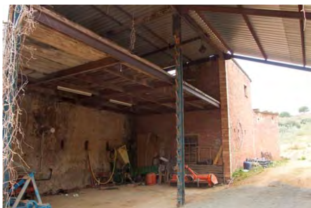
F9 Façana lateral nord-est (Volum A,B i C)
