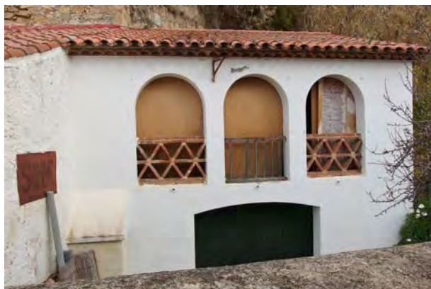
F3 Façana principal sud (Volum B)
