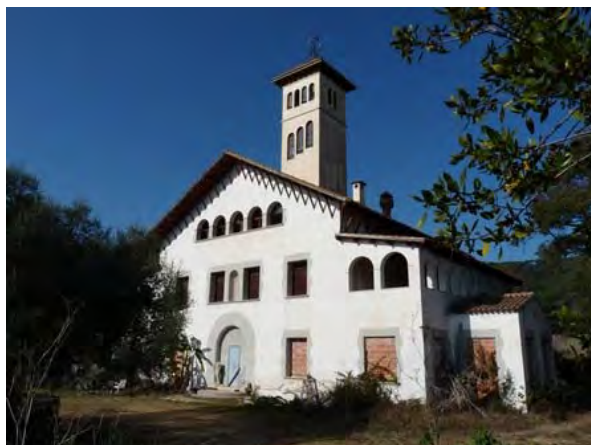
F6 Façana principal i lateral (Volum A)
