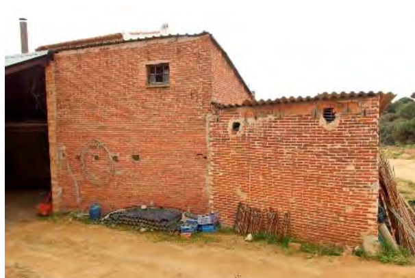
F6 Façana lateral sud-oest (Volums E,F, D i A)
