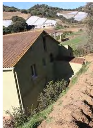
F4 Façana posterior sud-est (volum A i D)
