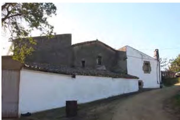
F5 Façana posterior nord-est (Volums B i C)
