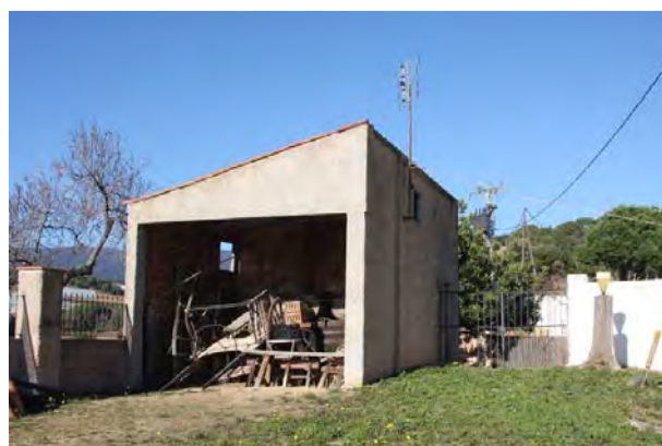
F10 Façana principal sud (Volum D)
