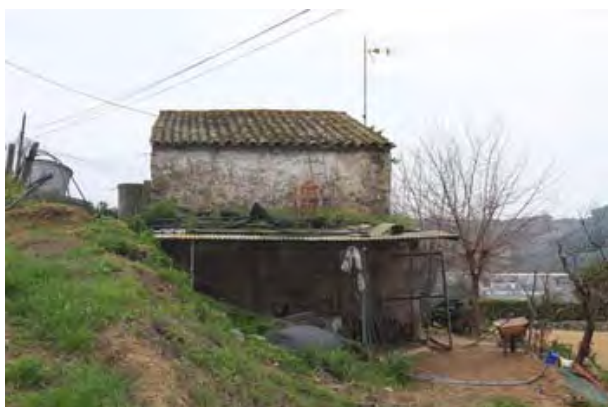
F5 Façana lateral nord (Volums A i D)
