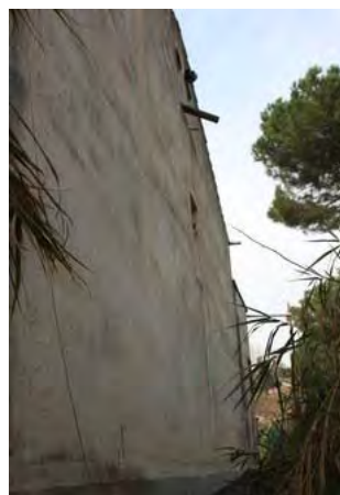
F8 Façana lateral nord-est (Volum A)
