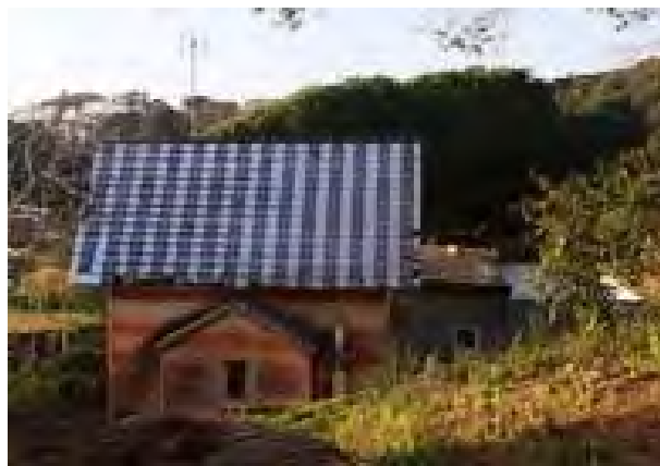
F4 Façana lateral nord volums A i B
