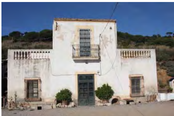
F3 Façana principal sud-est (Volum A)
