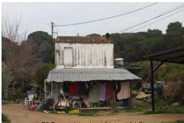
F9 Façana lateral sud (Volums A i C)
