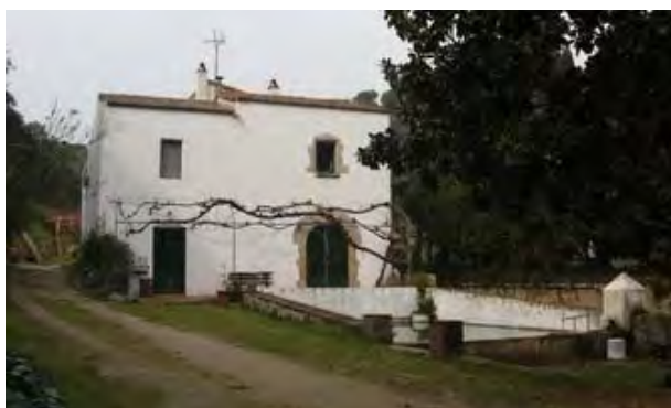
F7 Façana principal sud-est (Volum E)
