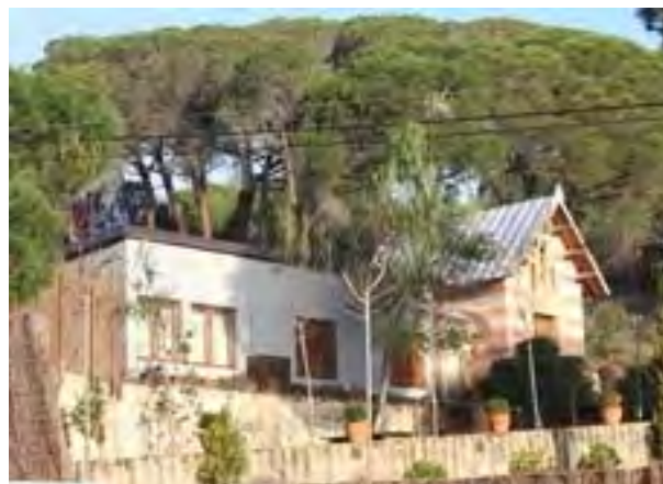
F2 Façana principal sud-est (Volums A i B)
