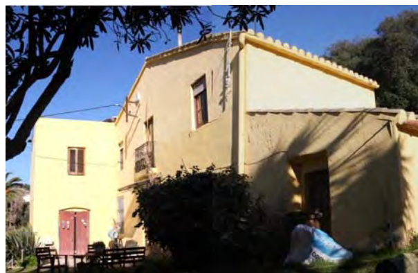
F2 Façana principal sud-oest (Volums A,B i C)
