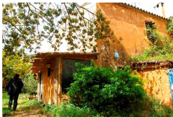
F4 Façana lateral (Volums B i E)
