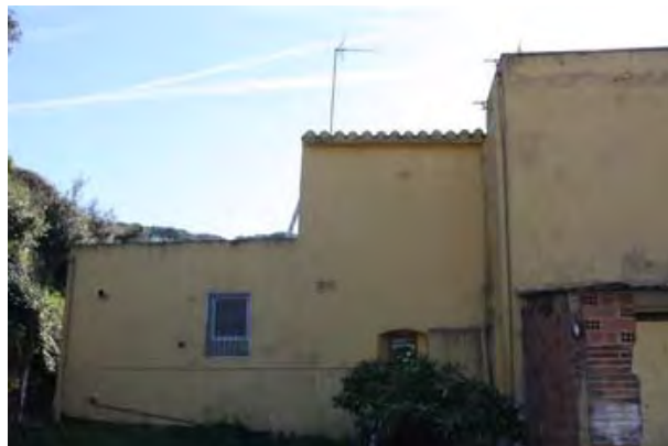
F8 Façana lateral nord (Volums A,B,D i E)
