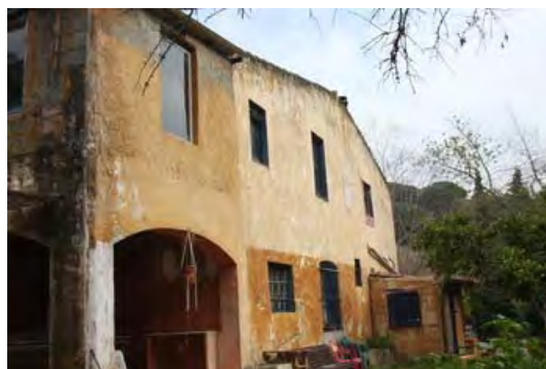
F2 Façana principal sud-est (Volums A, B i C)
