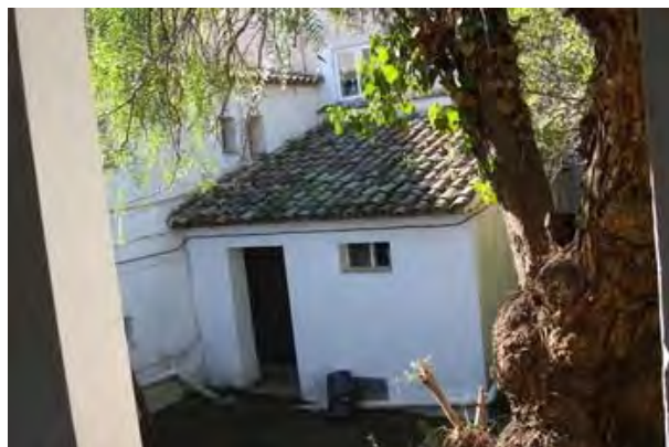
F6 Façana nord-est (Volum C)
