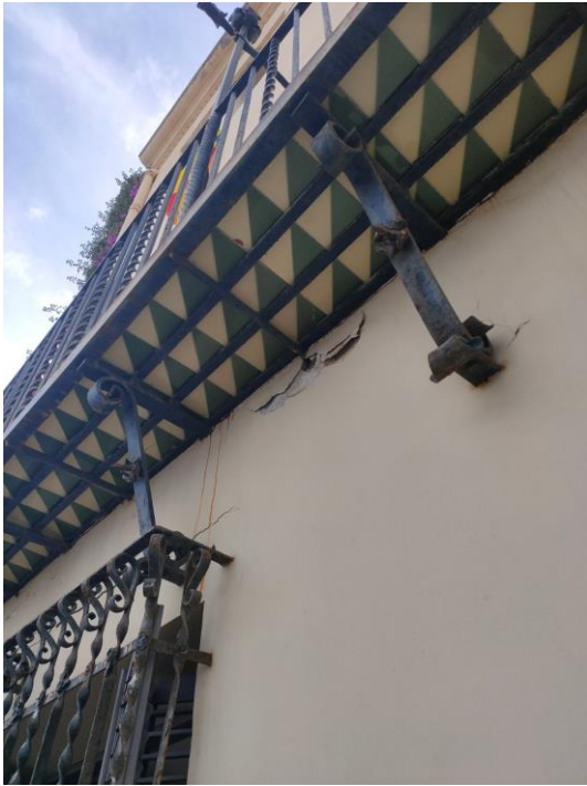
Vista inferior del balcó; elements de suport oxidats i afectació del revestiment.
