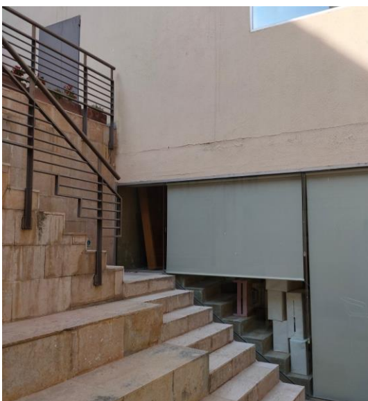
Esquerda horitzontal a nivell del forjat de planta primera, al llarg de la façana.
