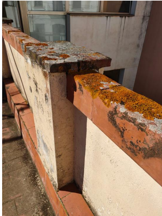
Detall del coronament amb líquens.
