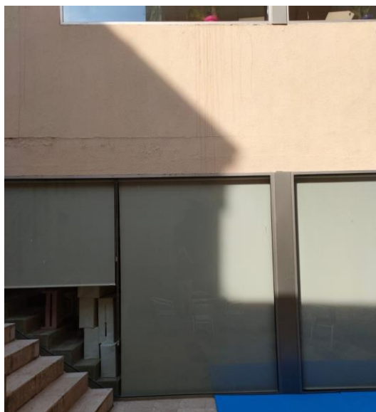
Esquerda horitzontal a nivell del forjat de planta primera, al llarg de la façana.
