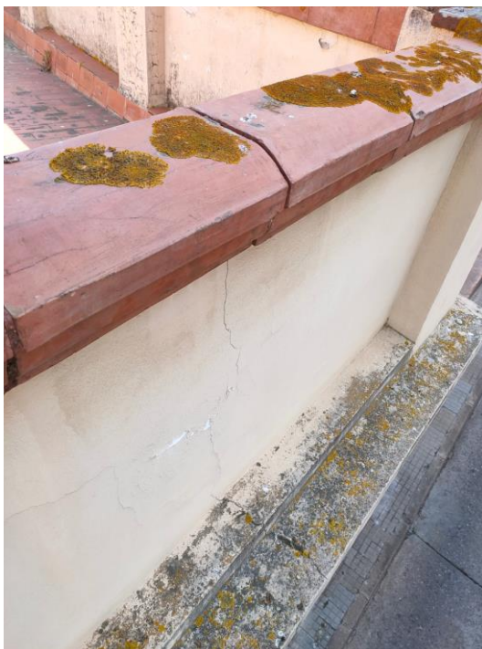
Esquerda vertical a l'ampit, tant a la peça ceràmica superior com a la part inferior, vista interior i exterior respectivament.
