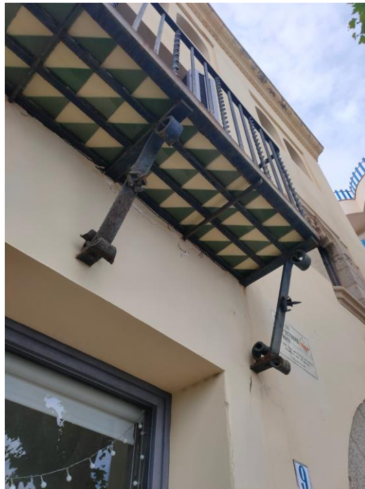
Vista inferior del balcó; elements de suport oxidats i afectació del revestiment.
