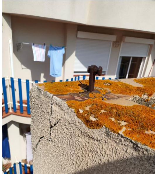
Peça de ferro a retirar i revestiment a reposar.
