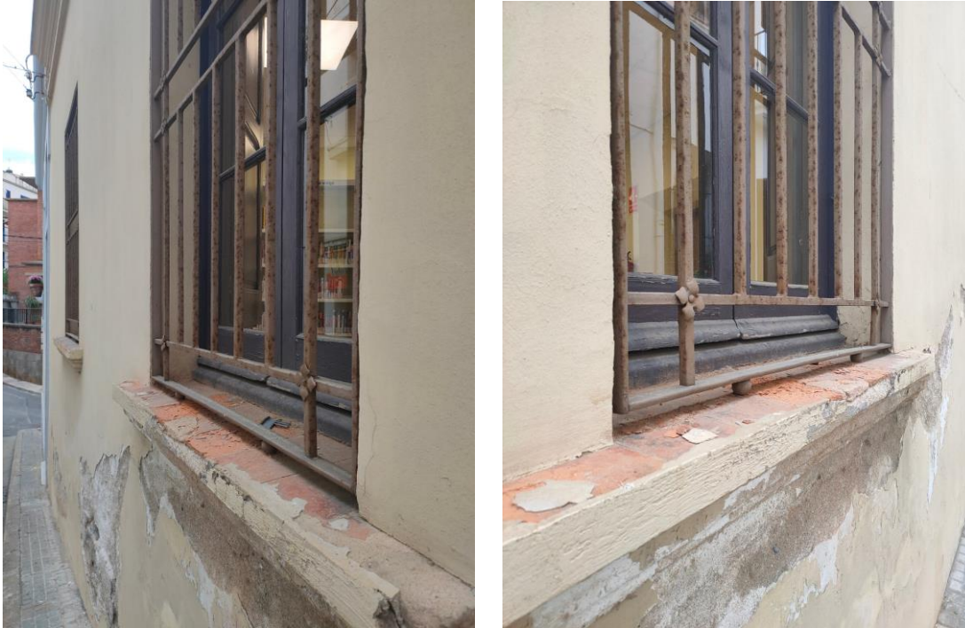
Finestres amb la fusteria de fusta, reixes de ferro i ampit en mal estat.
