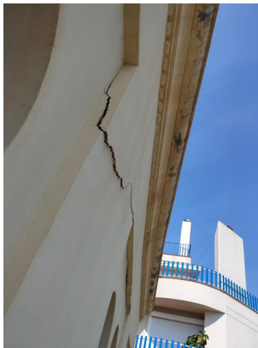
Esquerda horitzontal a la part central de la façana.
