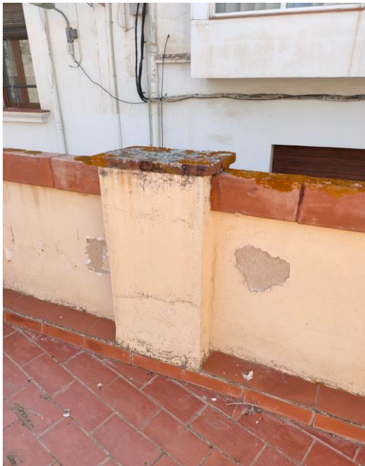
Ampit superior de la façana, vist des de l'interior, amb desprendiments del revestiment en alguns punts.
