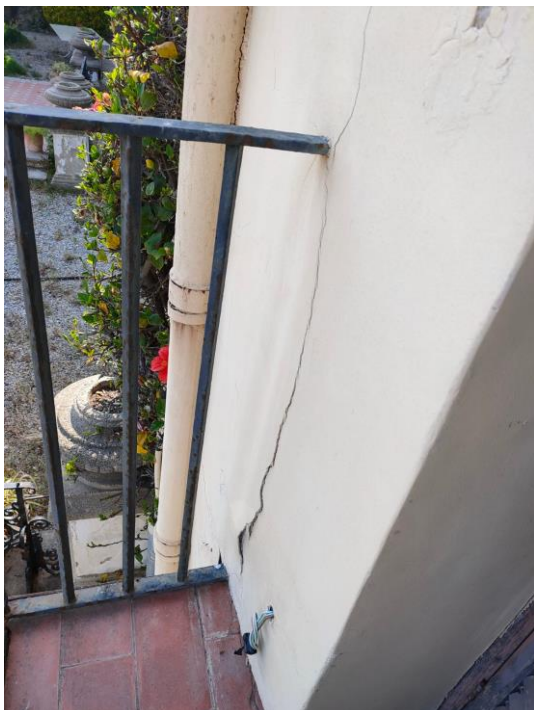
Oxidació de la barana de planta primera, banda dreta.
