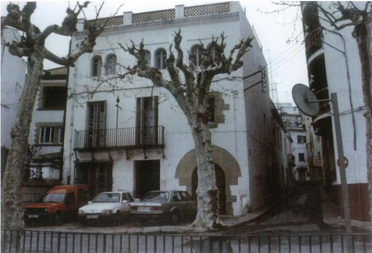
Imatge de la façana principal al carrer Consolat de Mar
