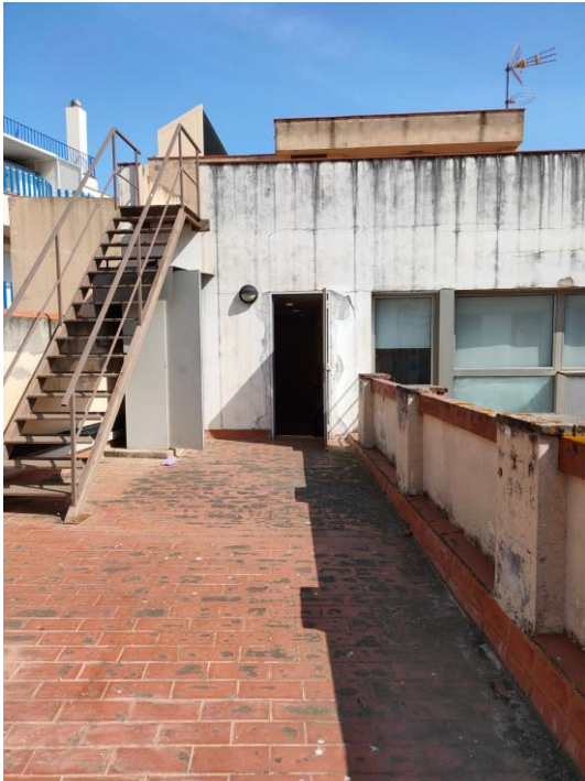
Façana posterior al pati interior.
