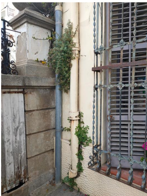
Part baixa del baixant d'aigües pluvials per la façana
