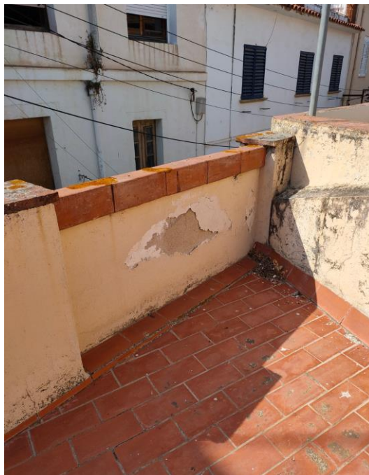
Ampit superior de la façana, vist des de l'interior, amb desprendiments del revestiment en alguns punts.
