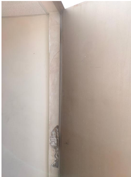
Detall de l'afectació a la cara interior de la façana.
