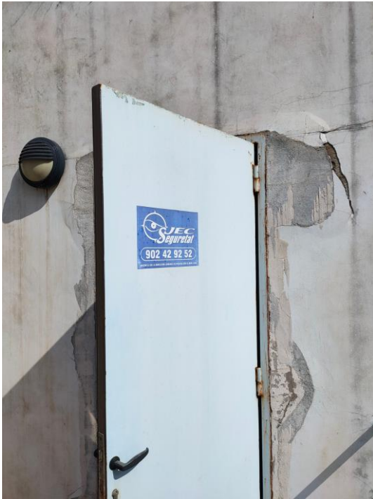
Oxidació del marc de la porta i afectació revestiment.
