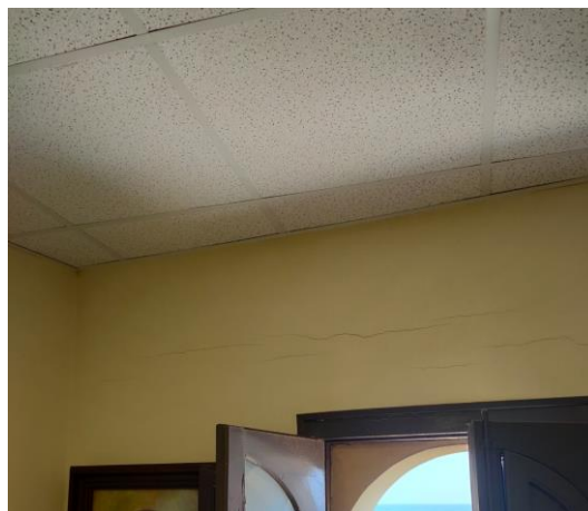
Esquerda interior, a la banda dreta de la façana.
