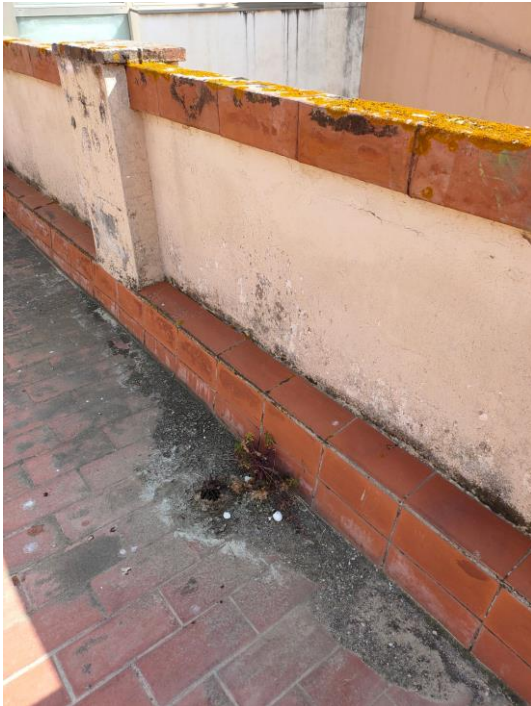
Barana d'obra i coronament ceràmic.
