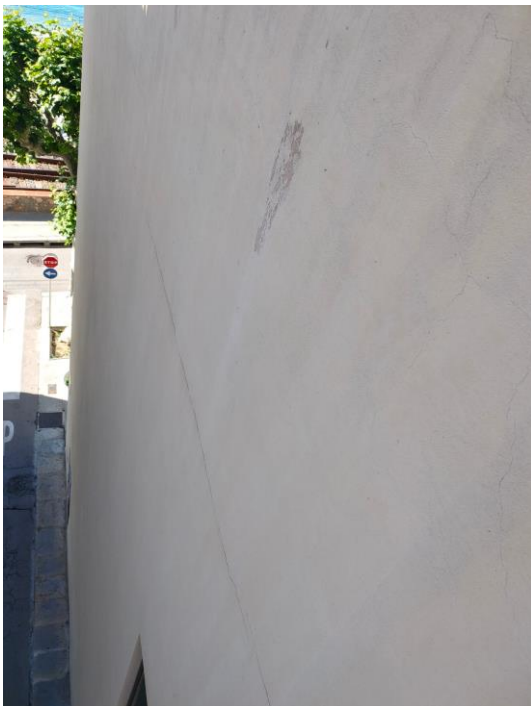
Esquerda horitzontal a nivell del forjat.
