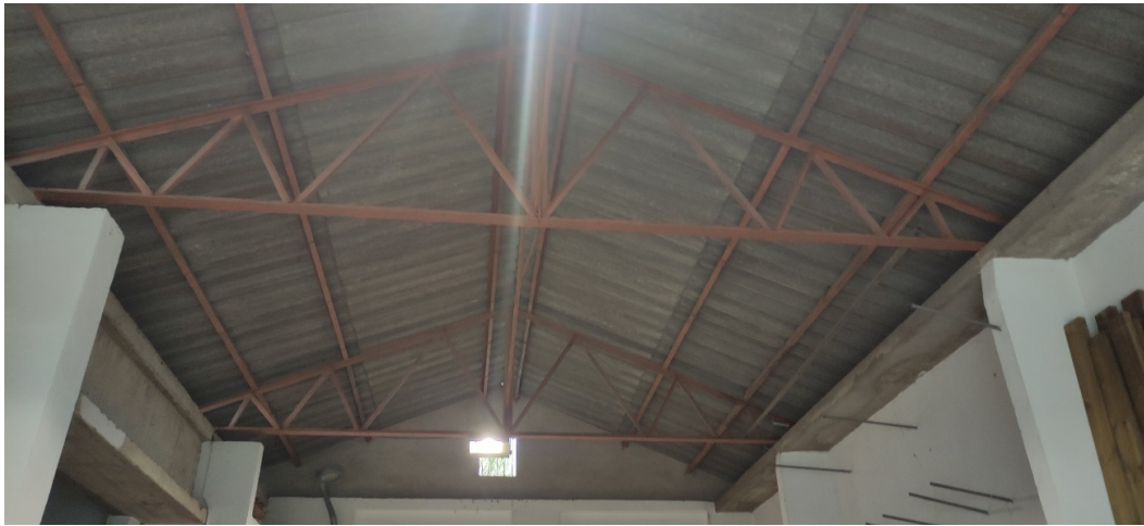
Foto 4: Detall interior encavallades nau.
