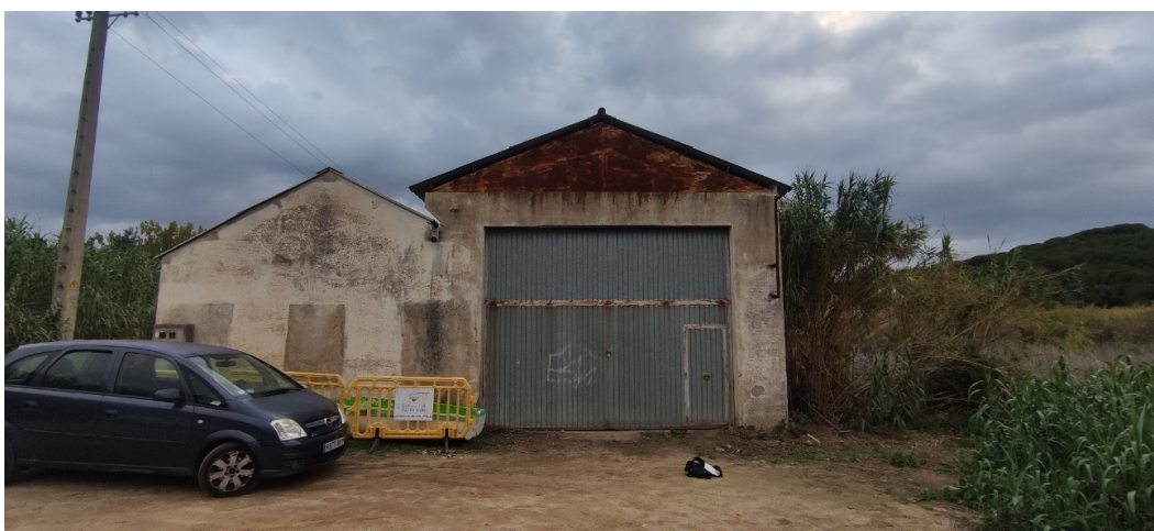
Foto 2: Detall exterior edifici.
