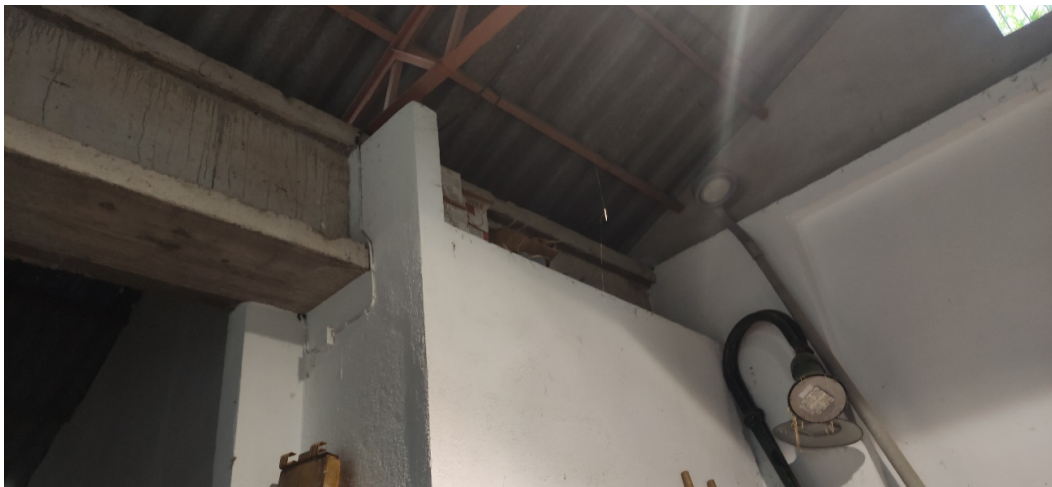
Foto 8: Detall interior encavallades nau.
