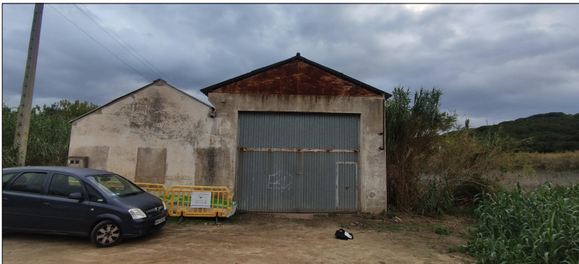
Façana principal, construcció agrícola objecte de la substitució de la coberta.
