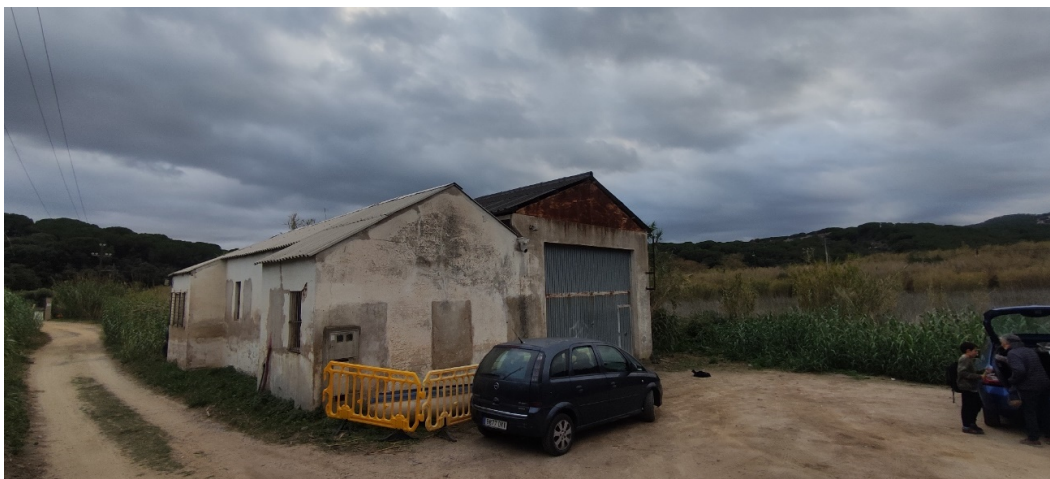
Foto1: Detall exterior edifici.
