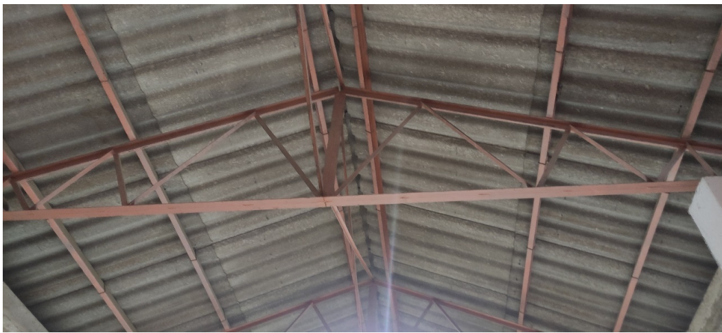
Foto 5: Detall interior encavallades nau.
