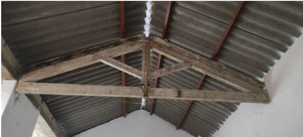
Foto 7: Detall interior encavallades fusta nau.
