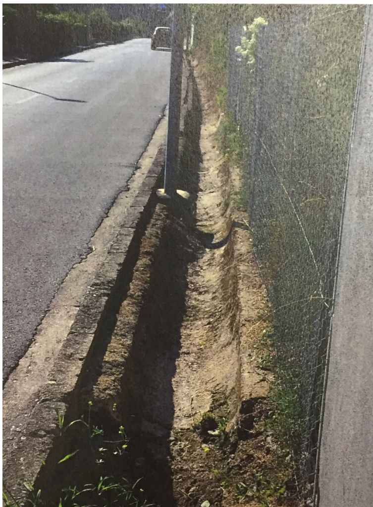
Figura 4.8: Exemple de canal a mitja canya, abans de ser cobert pels panots de la vorera.
