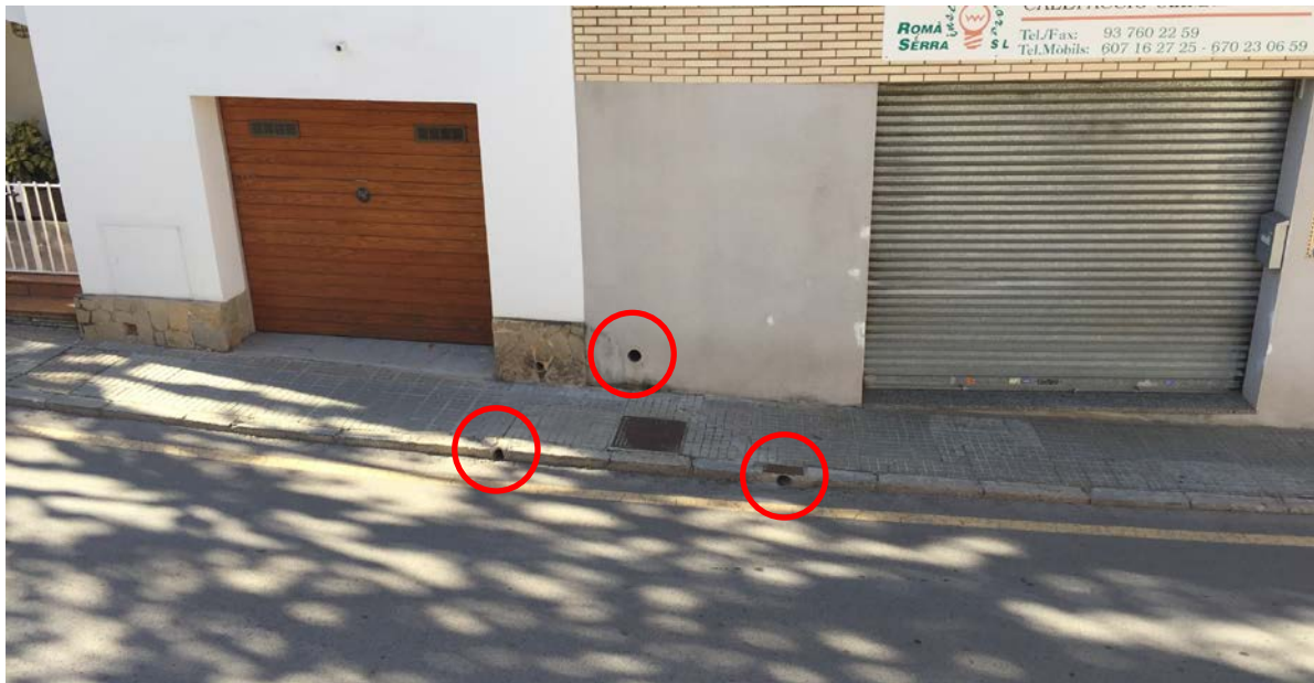
Figura 1.4. Exemples de sortides al carrer de les cobertes dels habitatges.
