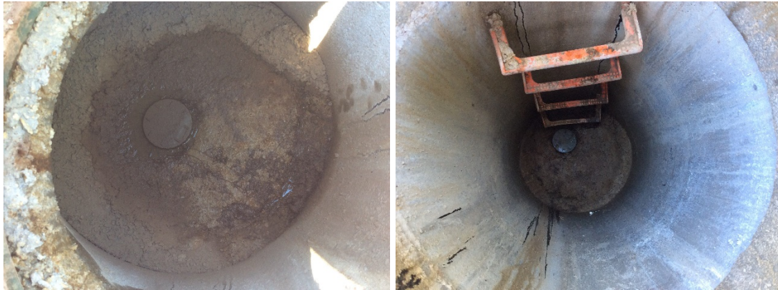
Figura 4.9: Exemples dels pous del Farell, on només és visible la solera i la tapa roscada sobre el tub PVC.
