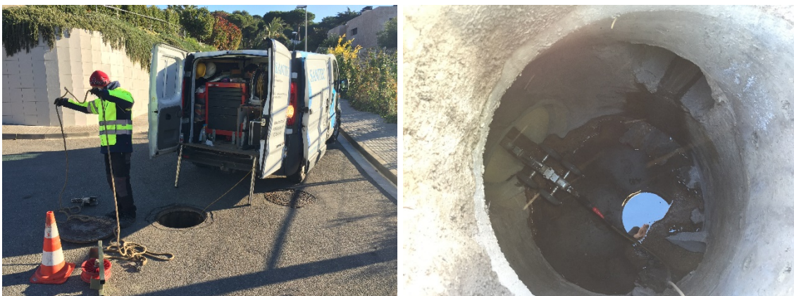
Figura 4.13: Furgoneta per al control i treball amb robot.
