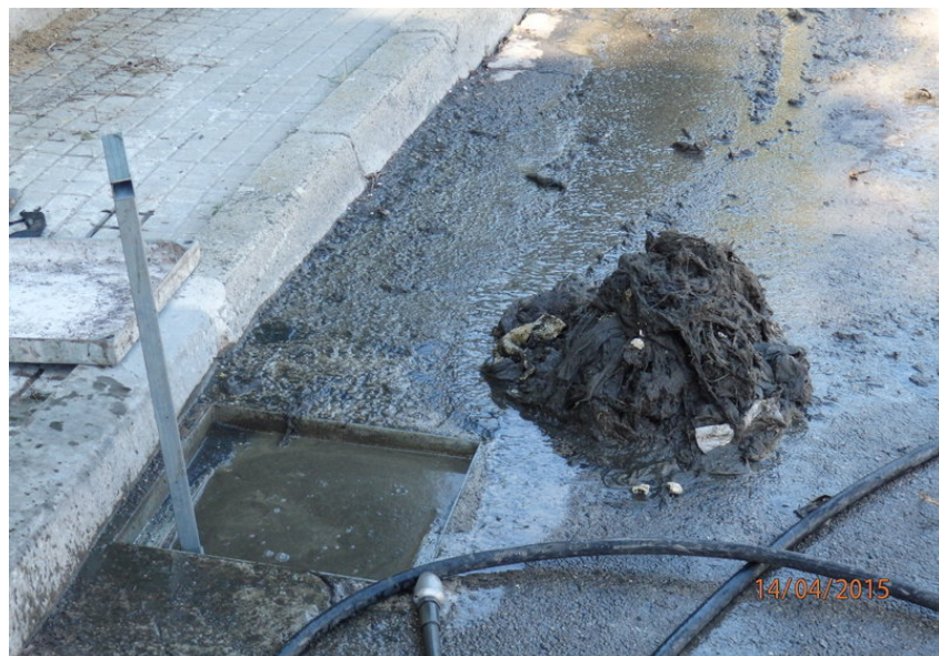
Figura 2.1: Problemes d'embussament per presència de tovalloletes (Imatge de l'any 2015. Font: www.elpuntavui.cat ).
