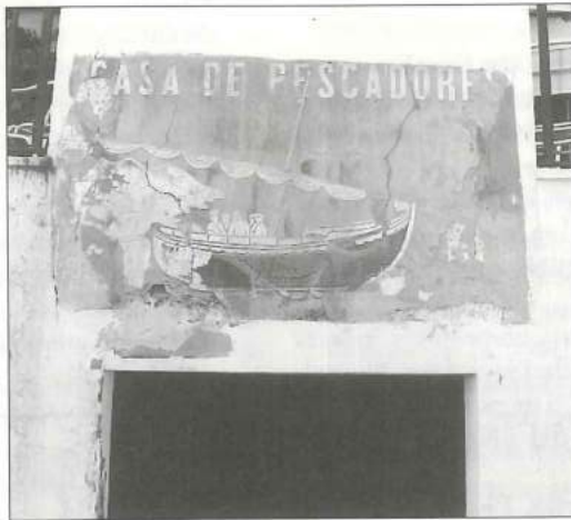
Relleu de la façana de la Casa dels Pescadors
