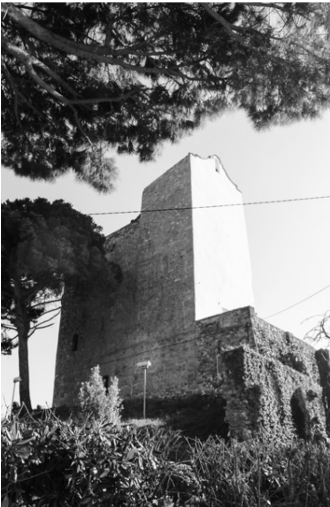
Les esquerdes a les façanes de l'ermita ja han desaparegut
