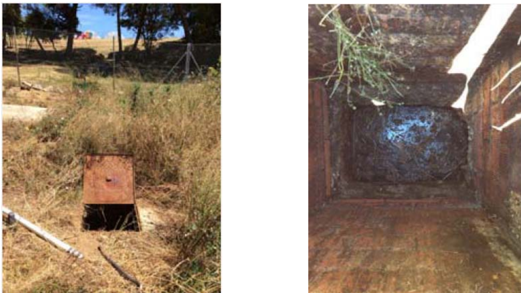
Figura 12: Inspecció de la fossa sèptica 1
