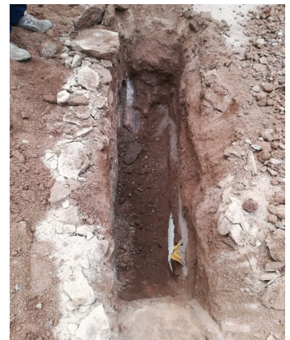
Vista de la calicata C-1
