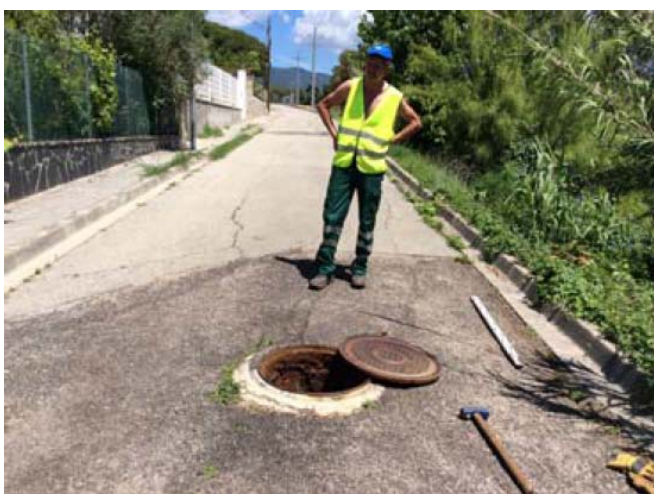
Figura 5: Pou previ a fossa sèptica (fosa 2) ple de residuals
