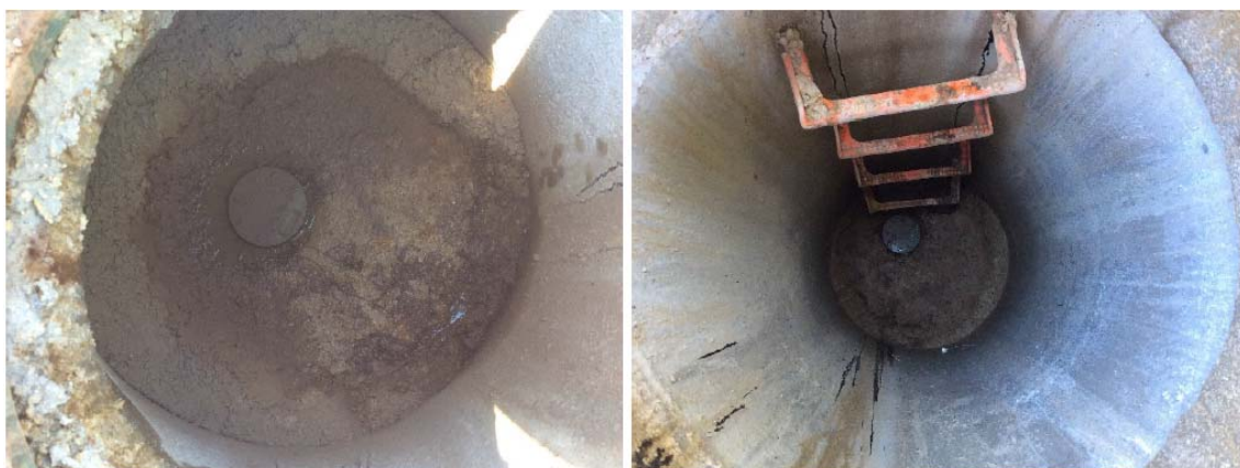
Figura 3: Exemples dels pous del Farell, on només és visible la solera i la tapa roscada sobre el tub PVC.
