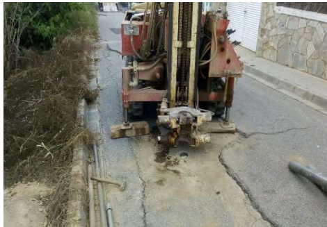
Equip Rolatec RL 48 L en el punt de sondeig S-1
