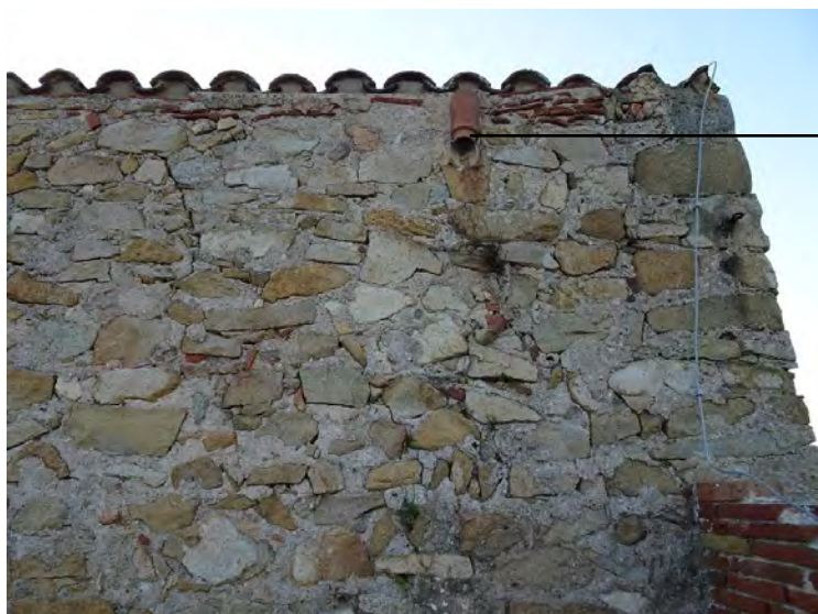
2.5.2. (3) Imatge de la coberta del cos de ponent; detall baixant
