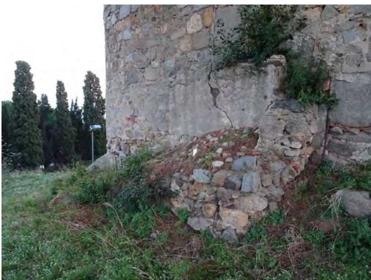
2.5.1.1. (3) Imatge façana nord, zona absis
