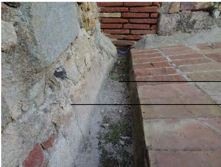
2.5.3.1. (2) Imatge del terrat de la nau, detall canal recollida d'aigua
