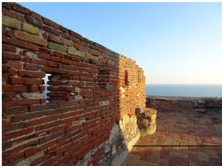
2.5.4. (1) Minvell perimetral i coronament mur façana
