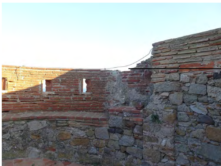
2.5.4. (1) Minvell perimetral i coronament mur obra fàbrica
