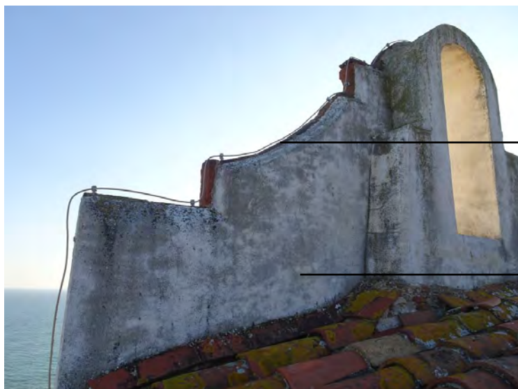
2.5.4. (3) Coronament i revestiment espadanyes
