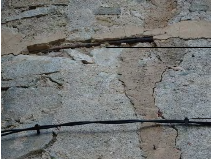
2.5.1.2. (3) Imatge façana est, zona absis; detall de la grapa de ferro
