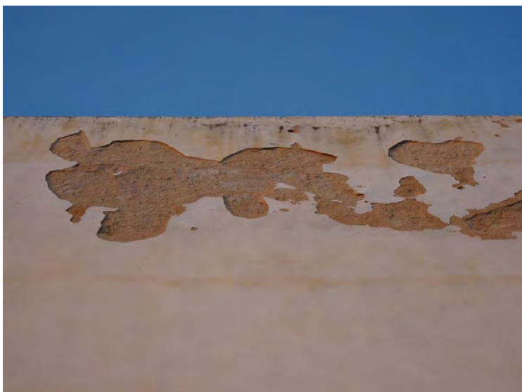
2.5.5. (2) Revestiment façana sud; detall
