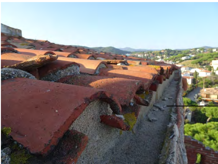
2.5.2. (2) Imatge de la coberta del cos de ponent; detall canaló
